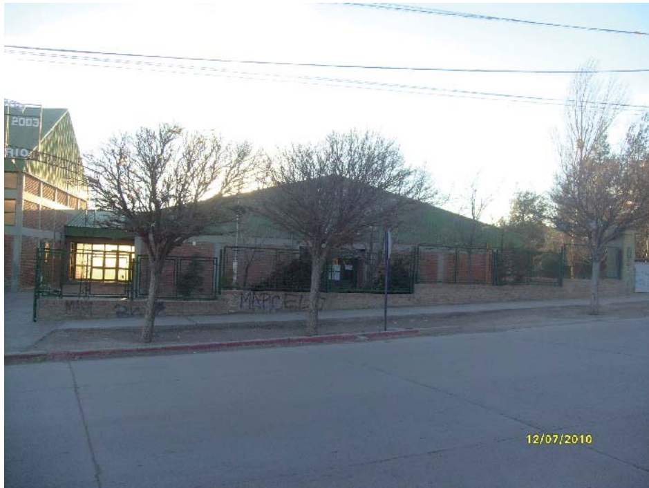
01-VISTA EXTERIOR DE ACCESO A SECTOR AULAS
