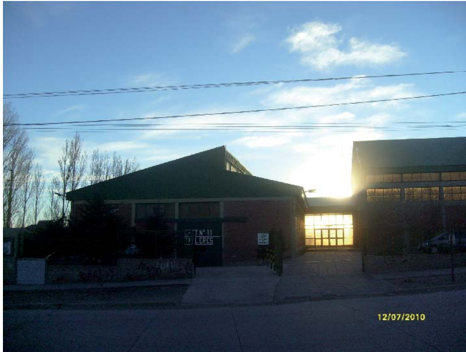
03 – VISTA EXTERIOR ACCESO SECTOR TALLERES
