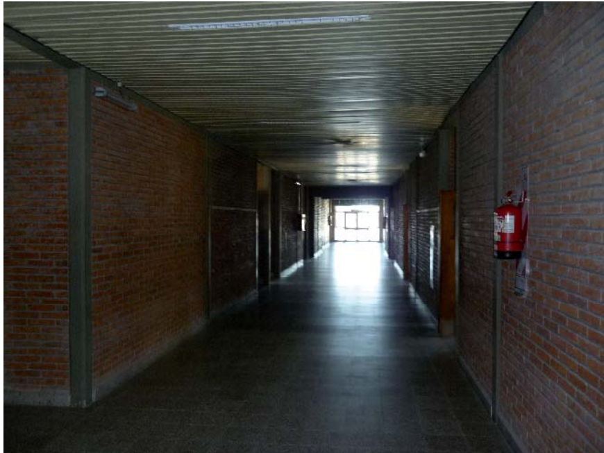
07 – VISTA INT. GALERIA HACIA SALIDA POSTERIOR (AULAS)
