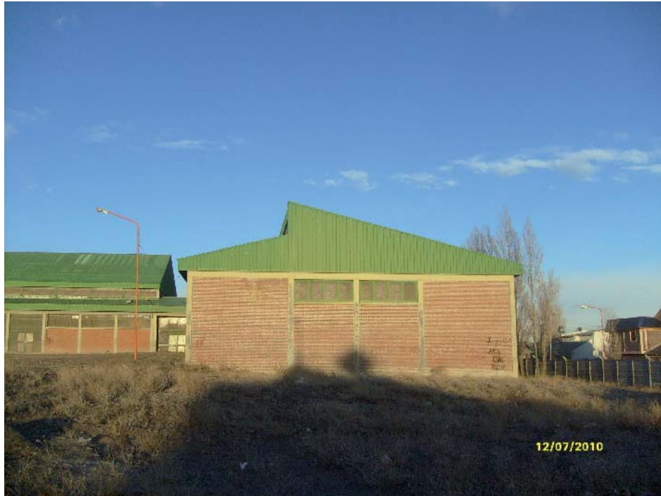
05 – VISTA EXT. POSTERIOR SECTOR AMPLIACION TALLERES
